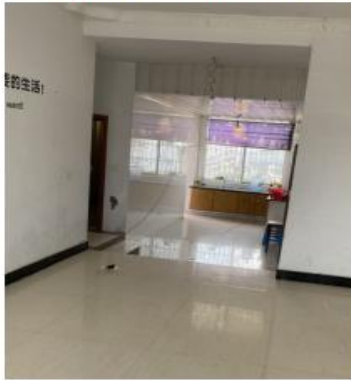
现状照片三：估价对象现状
