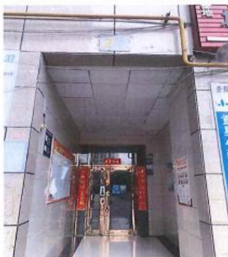
现状照片一：估价对象单元门
