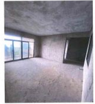
现状照片十：估价对象现状
