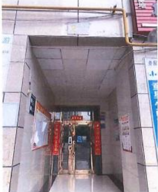
现状照片一：估价对象单元门
