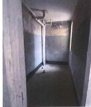
现状照片九：估价对象现状
