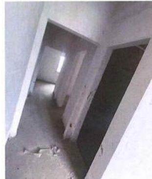
现状照片九：估价对象现状
