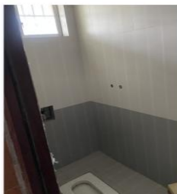
现状照片三：估价对象现状
