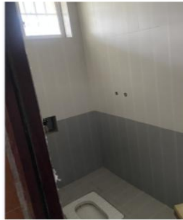
现状照片三：估价对象现状
