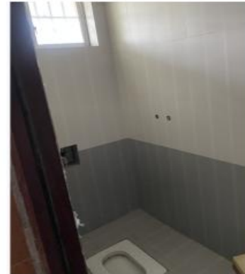
现状照片三：估价对象现状
