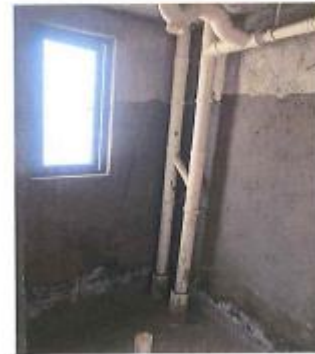
现状照片九：估价对象现状
