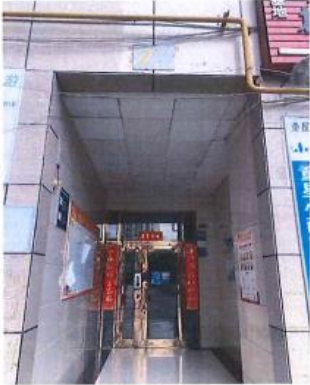
现状照片一：估价对象单元门
