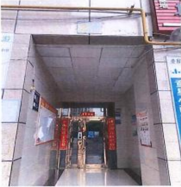
现状照片一：估价对象单元门
