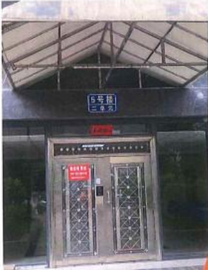
现状照片一：估价对象单元门
