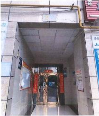
现状照片一：估价对象单元门
