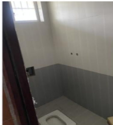
现状照片三：估价对象现状
