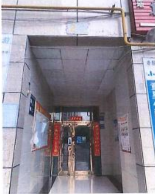
现状照片一：估价对象单元门
